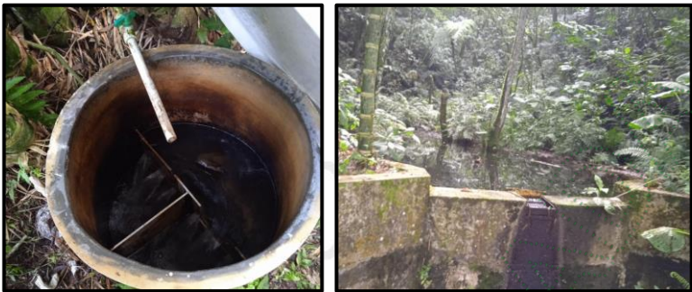
Imágenes 1 y 2: Obra de control de caudal implementada por el Acueducto y fuente hídrica “El Chusco”.
