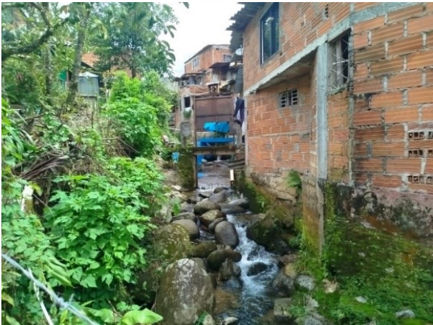
Figura 1. Vertimiento de aguas residuales domésticas sin previo tratamiento y obra de ocupación de cauce. Fuente: Cornare, 2024
