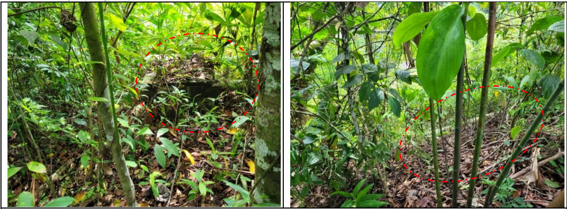
Figura 1. Estado actual red de conducción y MH, al alcantarillado del Corregimiento de Jerusalén
