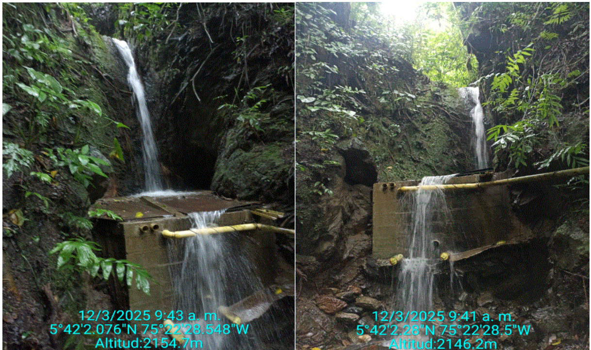
Captación Quebrada El Cedro. Tipo toma sumergida
