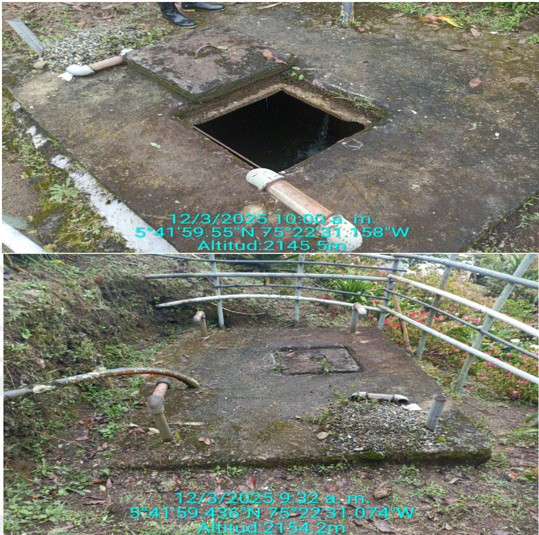
Tanque de almacenamiento capacidad para 11 m 3
