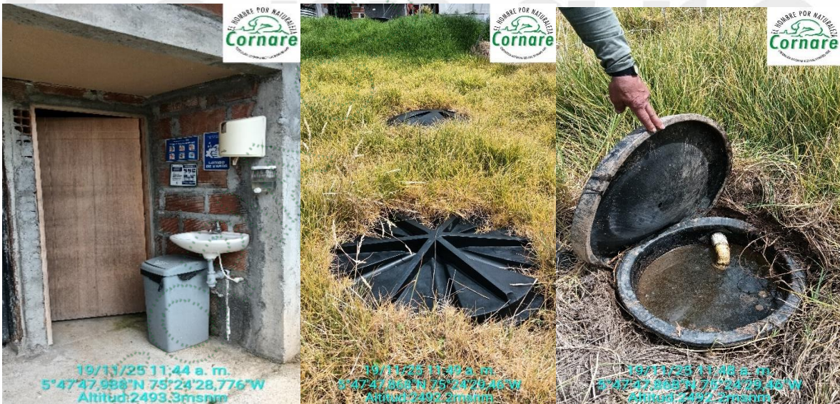
Unidad sanitaria bodegas – Stard y Pozo de desactivación
