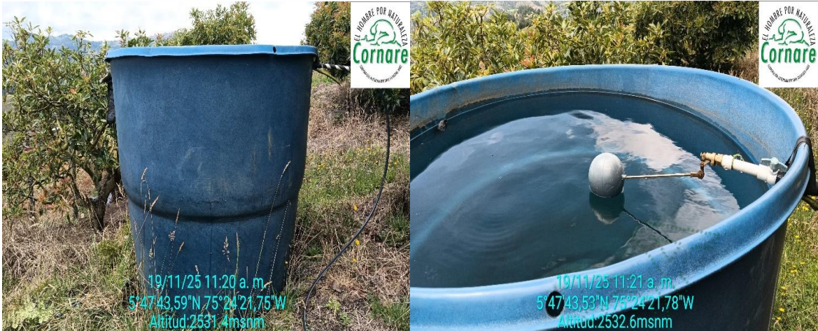
Tanques de almacenamiento con flotador y accesorios para control de flujo
