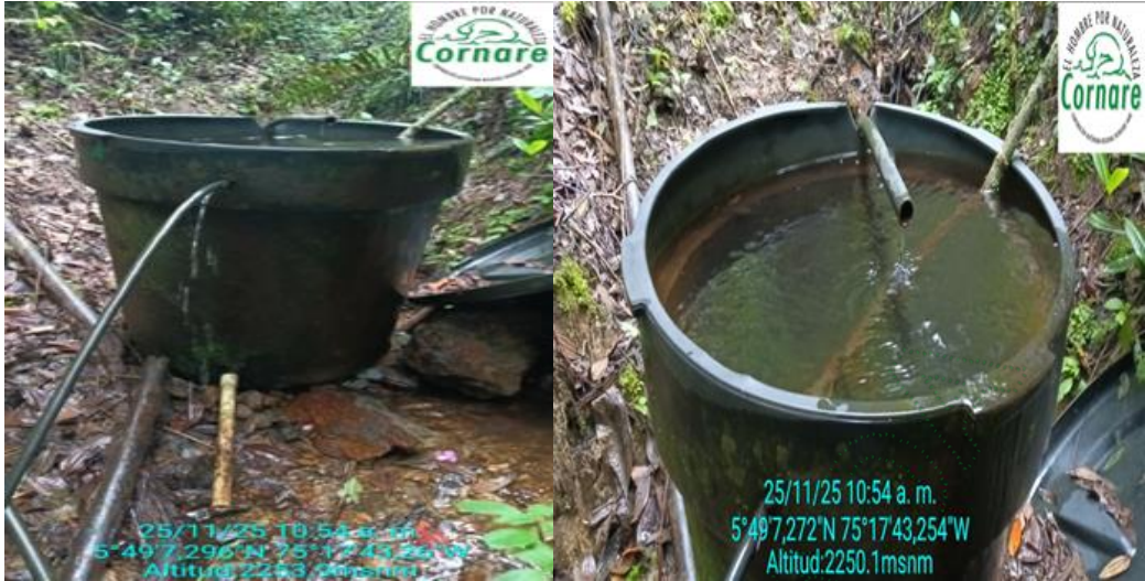
Desarenador fuente Los Rieles
