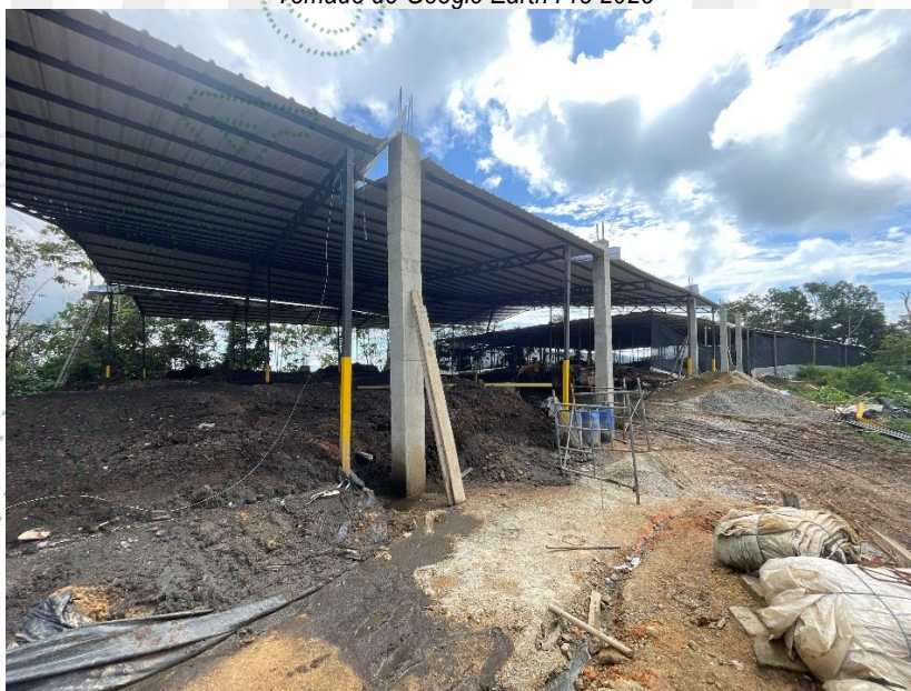
Figura 1. Estructura tipo galpón o cobertizo para almacenamiento de gallinaza. Fuente: Cornare 2025
