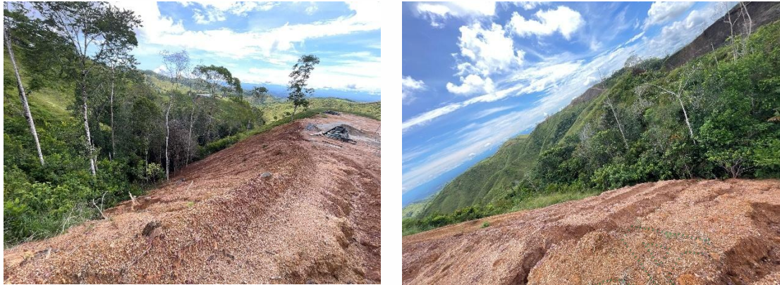
Figura 5. Taludes conformados para las explanaciones. Fuente Cornare 2025
