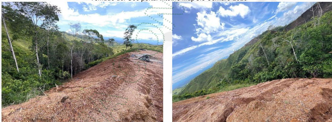
Figura 5. Taludes conformados para las explanaciones. Fuente Cornare 2025
