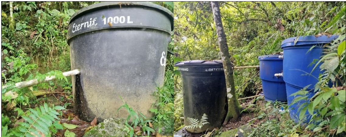
Figura 5. Primer tanque de 1000 litros a donde se deriva el recurso de la fuente. Figura 6. 2 tanques de 1000 litros (azules) y tanque de reserva de 2000 litros (negro).
