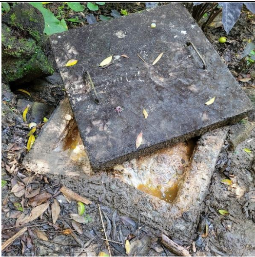
Imagen 19. Estado actual trampa de grasas Fuente: Visita de atención queja, 2025
