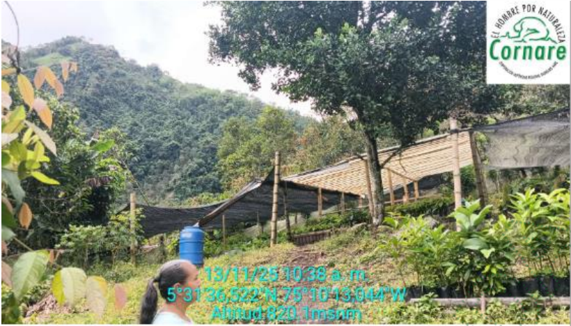
Techo en polietileno y polisombra con recolección de aguas lluvias
