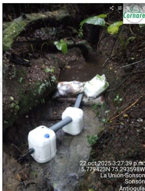
Obra de control de caudal en la fuente La Sierra, con tuberías de 3 pulgadas sin orificio de control
