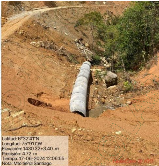
Imagen 5. Tubo de captación de la fuente sin nombre.
