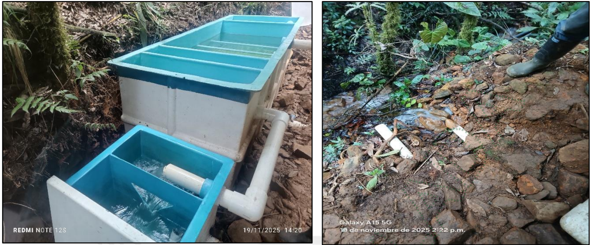
Figura 1. Obra de control de caudal y rebose a la fuente hídrica A continuación se presenta el aforo realizado del caudal derivado por el acueducto:
