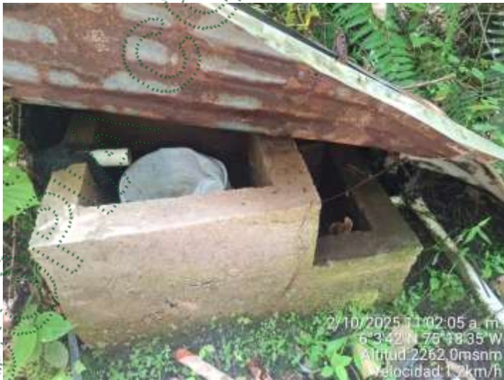
Imagen 3. Obra de captación y control en desuso.
