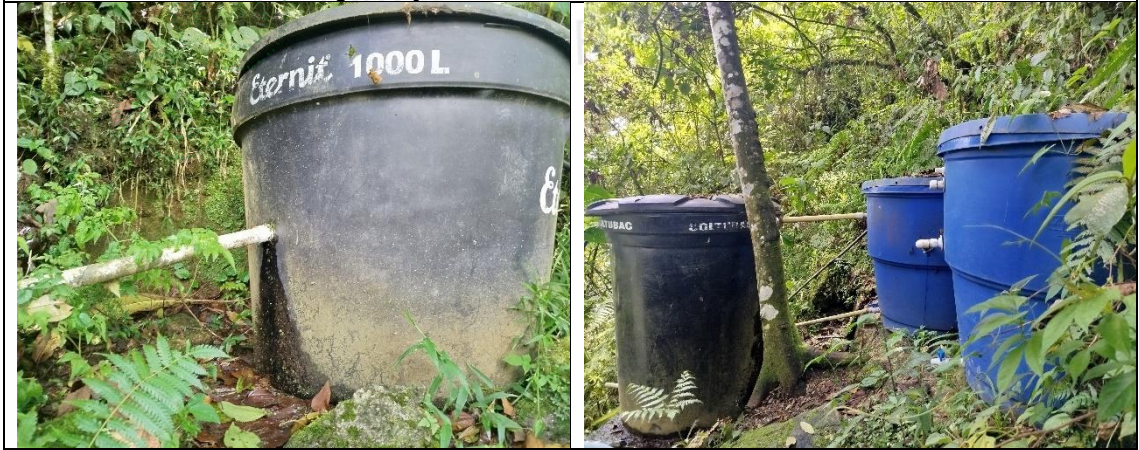
Figura 5. Primer tanque de 1000 litros a donde se deriva el recurso de la fuente.
