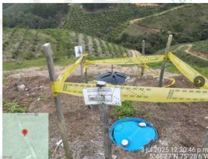
Pozo de desactivación en bodega y Baños
