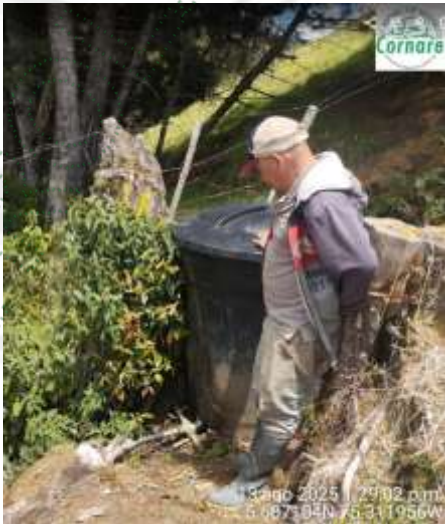
Sistema de almacenamiento
