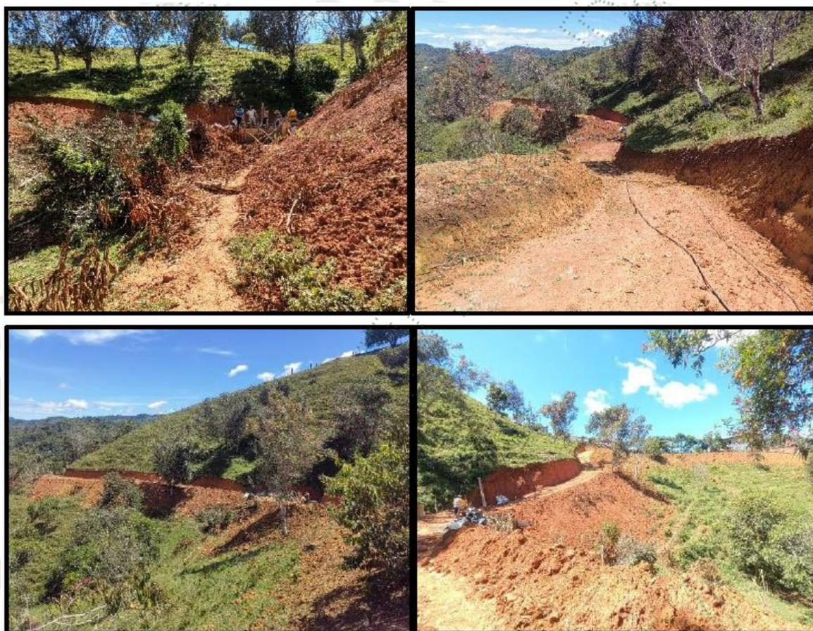
**Imagen 5.** Comare. 2025. Arrastre de material, y taludes ascendentes y descendentes de la vía.
