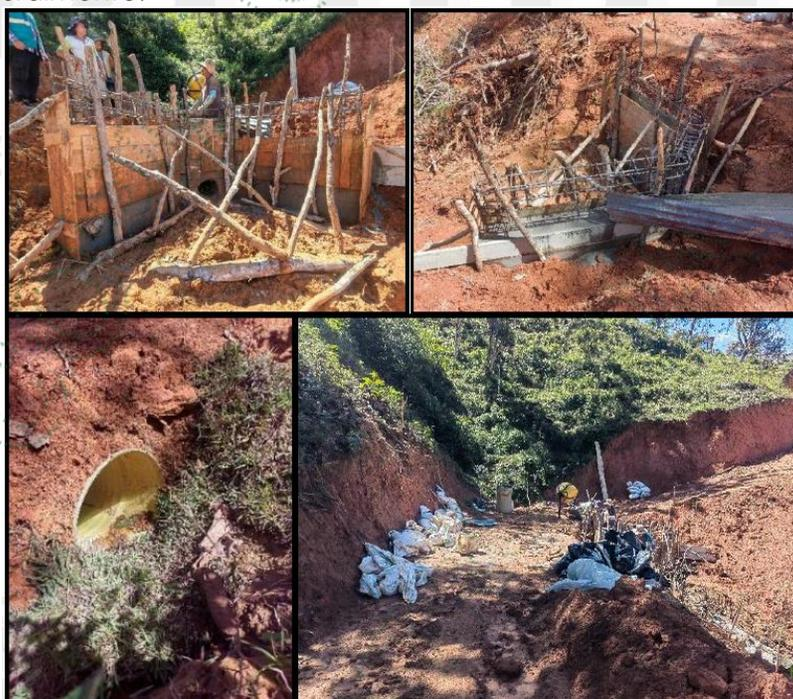
**Imagen 4.** Cornare. 2025. Obra de drenaje transversal para encausar el arroyo intermitente.
