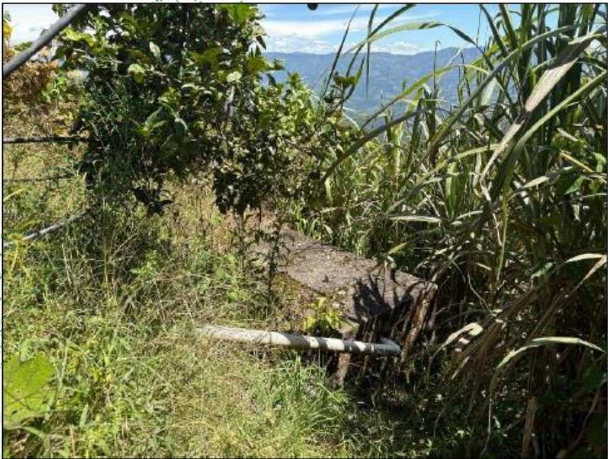
Imagen 4 Pozo Séptico Mampostería.
