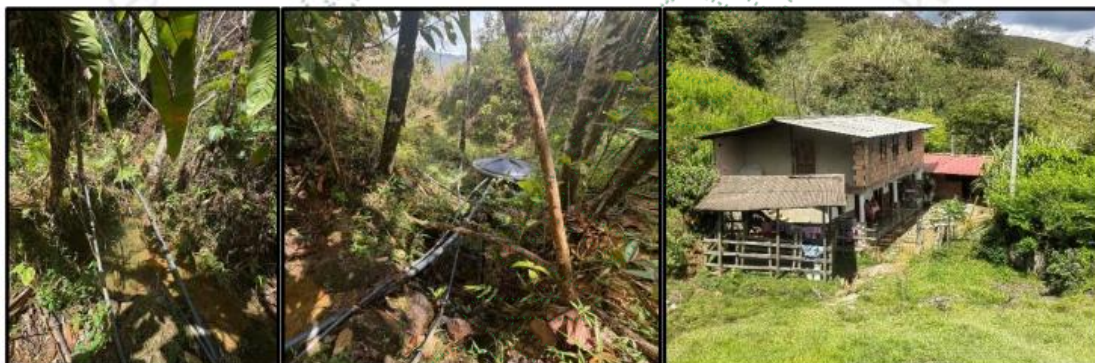
Imagen 5. Cornare. 2025. Toma del agua y vivienda del señor Jesús Edison Lopez.
