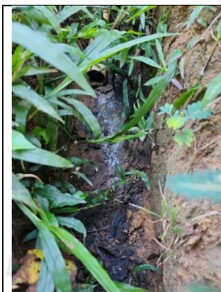
Imagen 4. Zanja en tierra que conduce a pozo. Cornare 2025.
