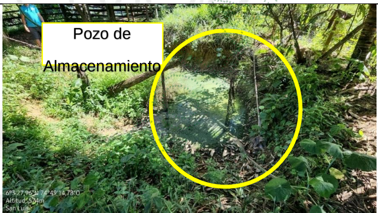
Imagen 5. Pozo de almacenamiento de residuos en visita el 07/07/2025. Cornare 2025.
