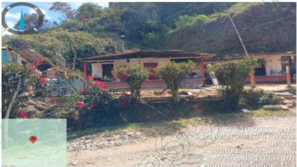
Imagen 3. Ubicación de la vivienda
