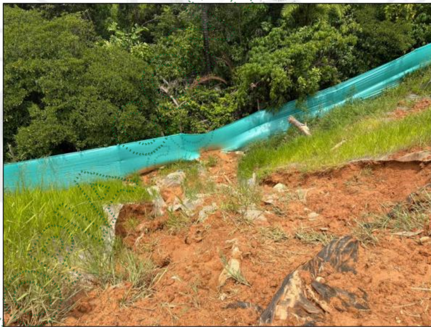
Figura 8. Lona verde como barrera para retener sedimentos
