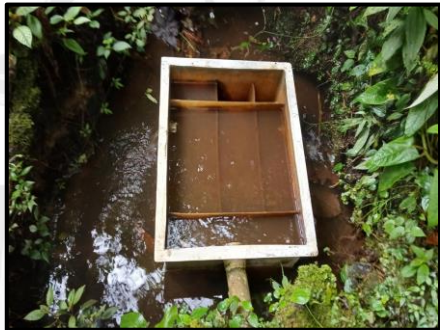
Imágenes 6, 7 y 8: Fuente hídrica “El Yarumo”, captación y desarenador de la sociedad Nebraska S.A.S.
