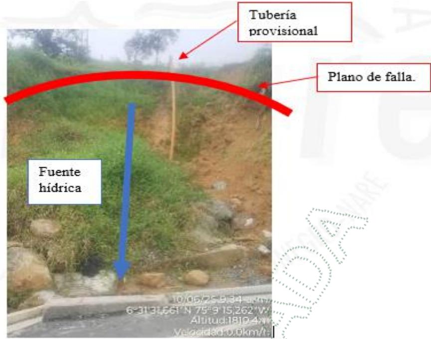
Ilustración 1 Deslizamiento talud.
