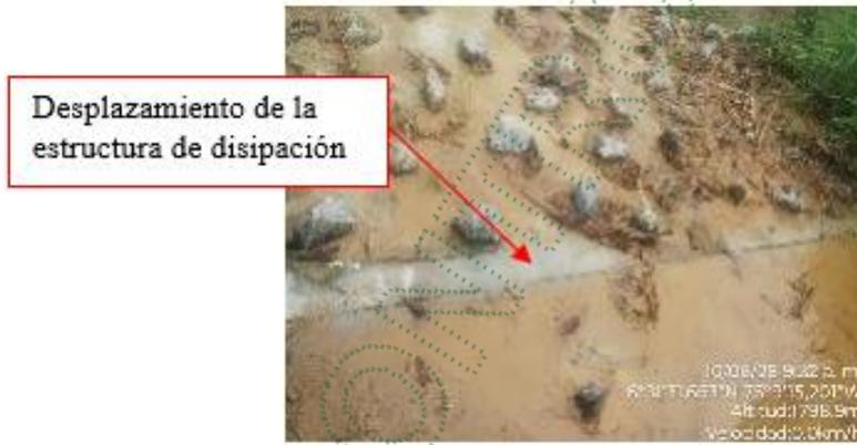
Ilustración 2 Grieta entre cabezote y estructura de disipación.
