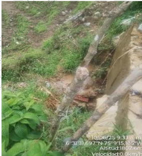
Ilustración 3 diferencia de altura entre disipadores y lecho natural.
