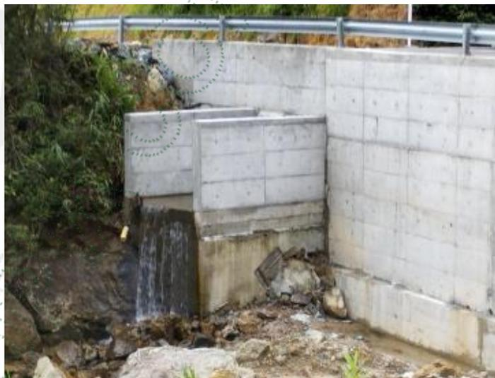
26.12. Se construyó un box culvert con las siguientes dimensiones (ancho 2.0m, alto 1.50m, longitud 8.80m aproximadamente), en las siguientes coordenadas:
