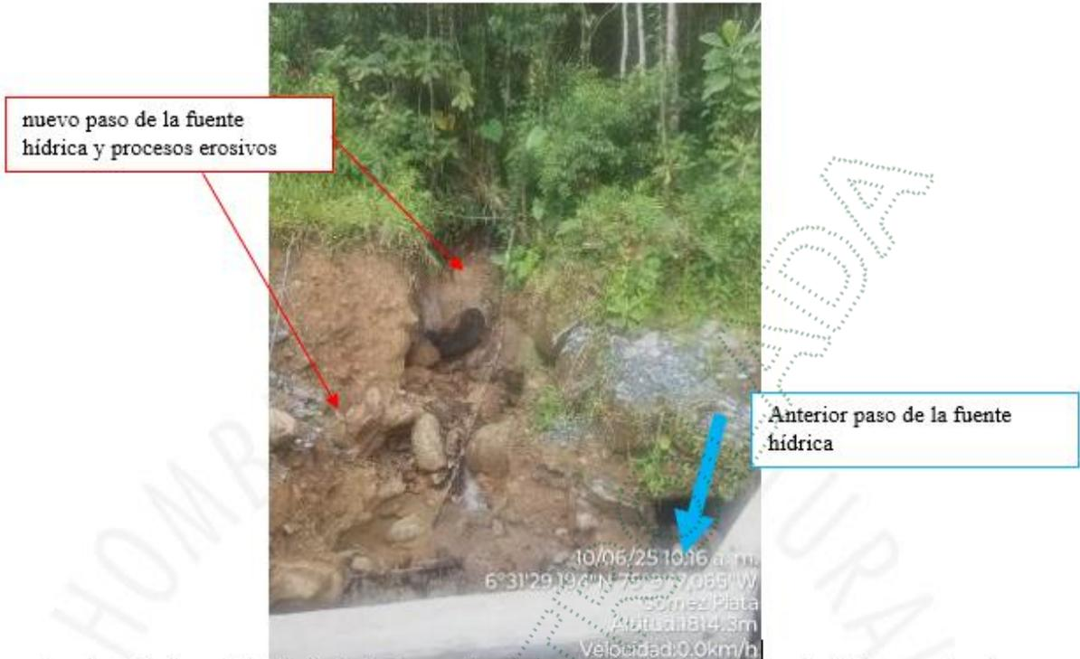
Ilustración 4 cambio de flujo de la corriente aguas arriba del cabezote del box culvert
