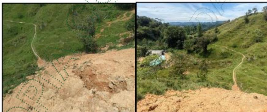
Imagen 3. Cornare. 2025. Camino de herradura parcialmente obstruido por el material de lleno.
