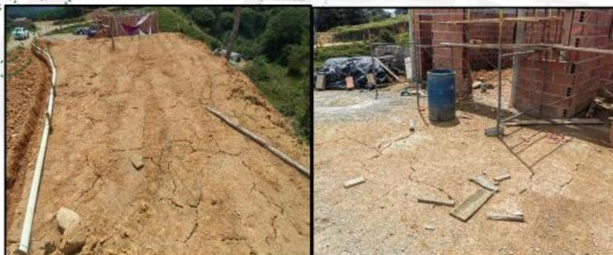
Imagen 4. Cornare. 2025. Estado de la superficie utilizada como lleno en la zona 2 (izquierda) y zona 3 (derecha).
