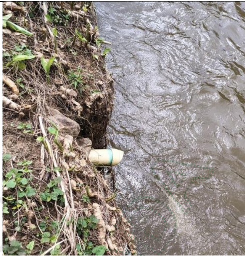
Estructura de descarga sobre la quebrada La Mosca
