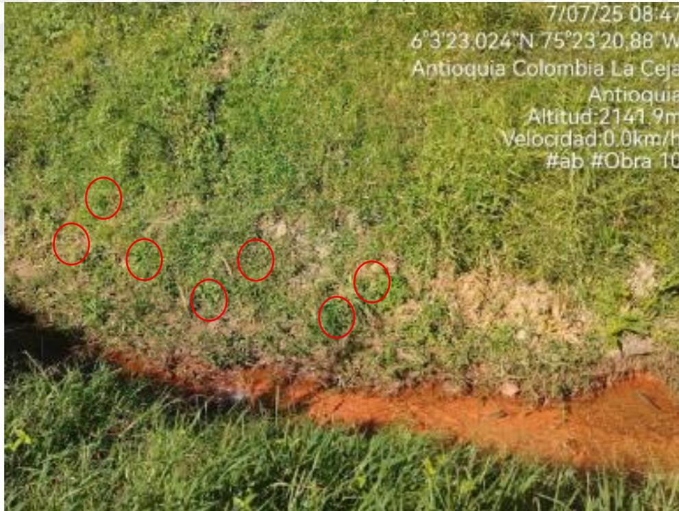
Ilustración N° 9. Revegetalización natural de taludes del canal trapezoidal y siembra de Vetiver
