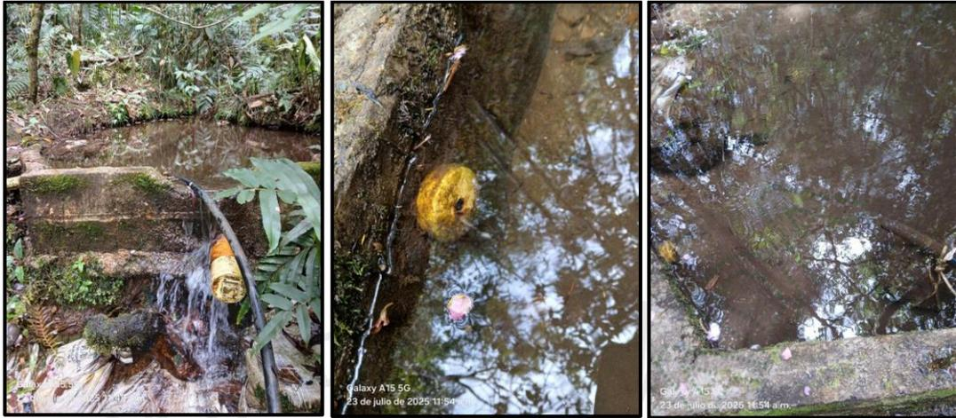
Imágenes 4, 5 y 6: Captación directa con manguera hallada en la fuente “La Palmita” y tubería sumergida fuera de operación
