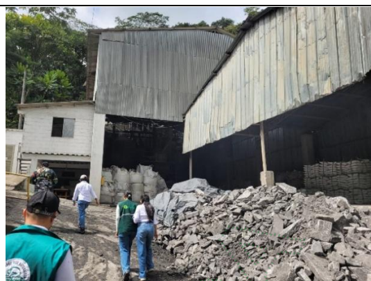
Imagen 2. Área de molienda y almacenamiento
