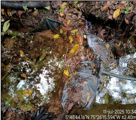
Captación La Toma 1, fuente hidrica La Toma
