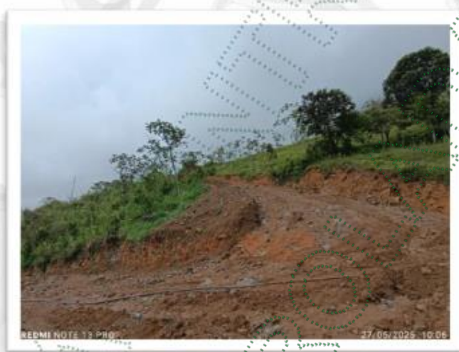
Fotografía 2. Vía construida en cercanías al cultivo de caña. Fuente: Cornare, 2025
