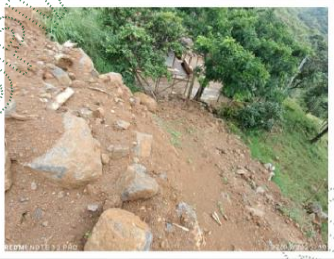
Fotografía 3. Movimiento de tierra cercano a una vivienda.
