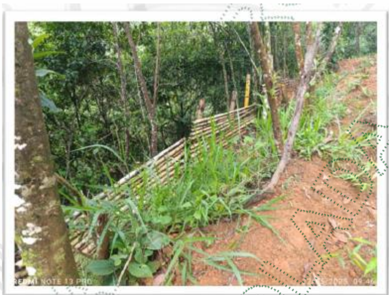
Fotografía 6. Uso de guadua improvisado para evitar deslizamientos.
