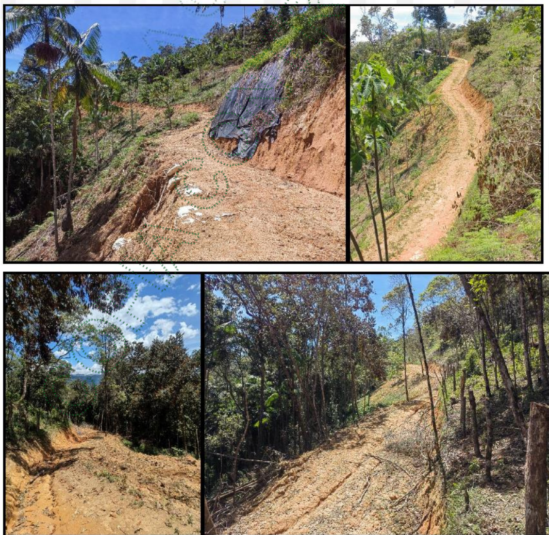
Imagen 1. Cornare. 2025. Estado de la vía aperturada en el área intervenida recientemente (2024-2025).
