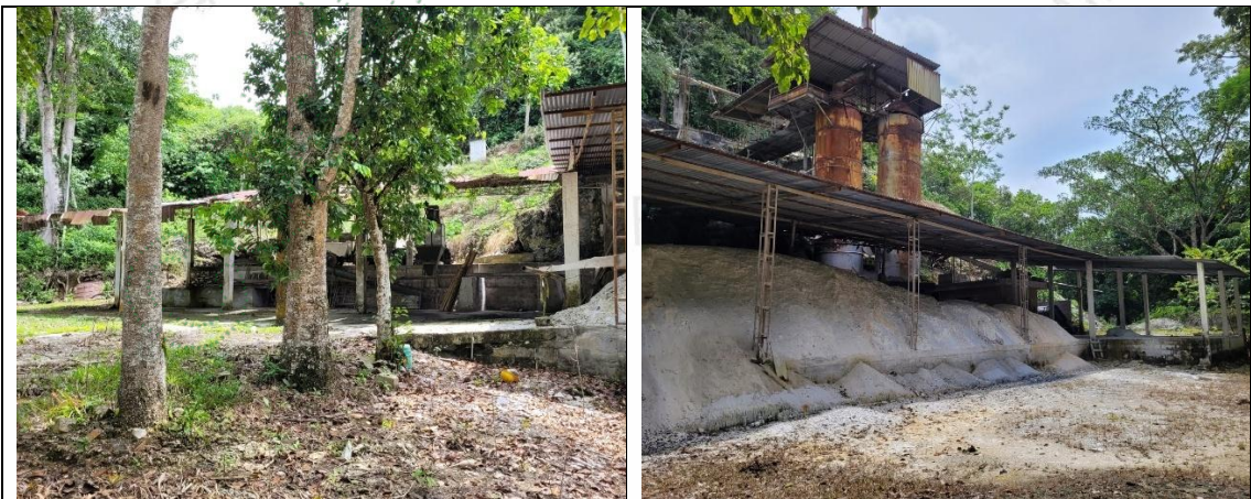
Imagen 1 y 2. Infraestructura existente en el predio identificado con FMI 028-24343 y PK_PREDIOS 7562006000000900018
