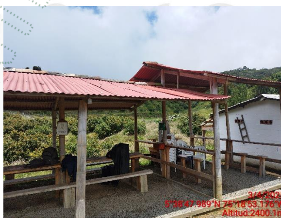
Comedor área administrativa
