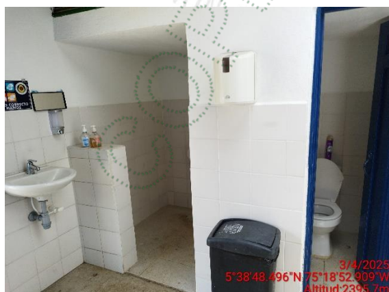
Unidad Sanitaria área administrativa
