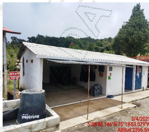
Zona de bodega y unidades sanitarias
