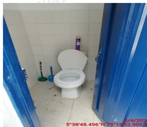
Unidad Sanitaria área administrativa
