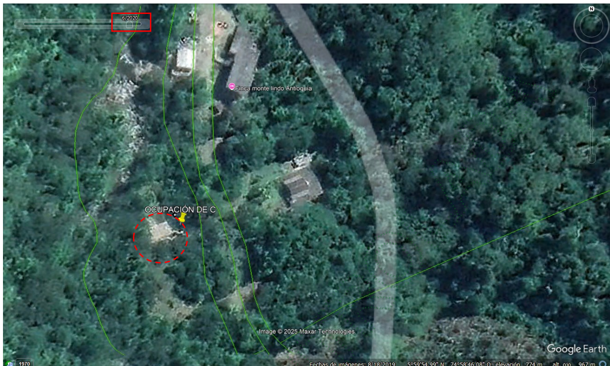
Imagen 2. Ortofoto del predio "Finca Montelindo" sobre el sitio donde está la obra de Ocupación de Cauce para el año 2020. Tomado de Google Earth Pro
