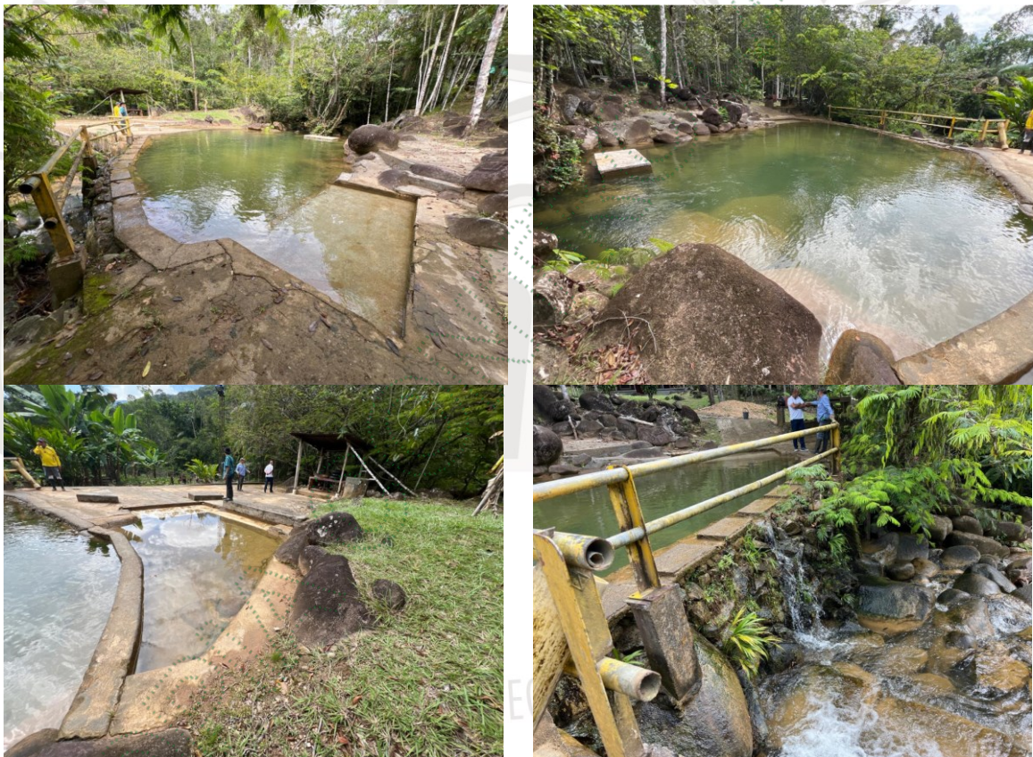
Fotos 8, 9, 10 y 11. Obra de ocupación e cauce sobre la quebrada La Habana Fuente: Cornare 2025
