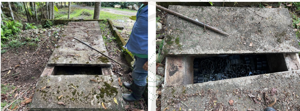
Foto 6 y 7. Tanque séptico de la Finca Montelindo. Fuente: Cornare2025
