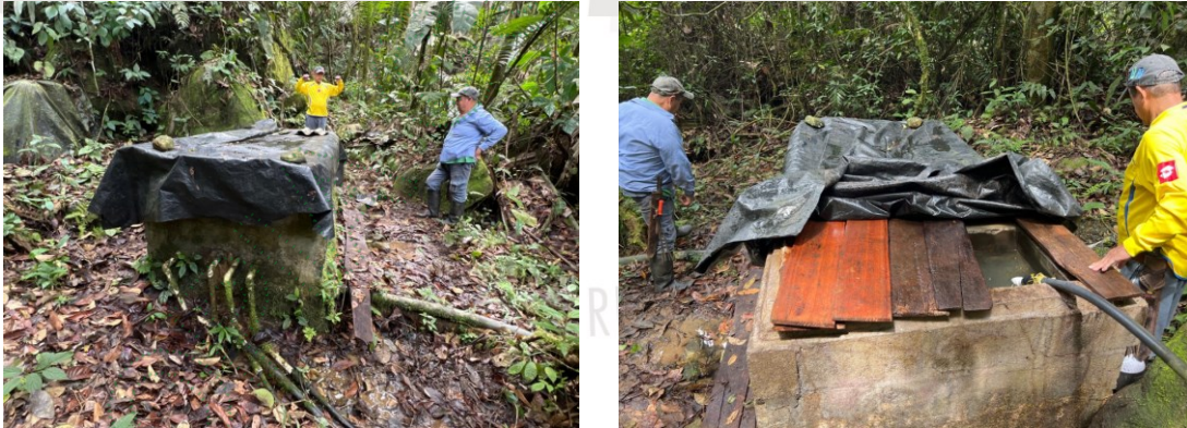
Foto 3 y 4. Tanque desarenador y almacenamiento Fuente: Cornare 2025
