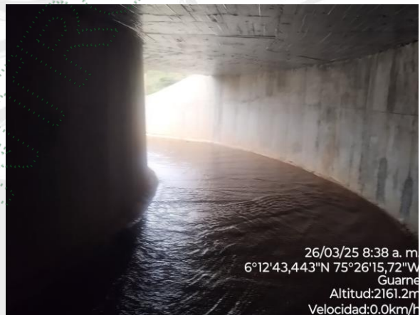
Ilustración 19 Parte final del box culvert
