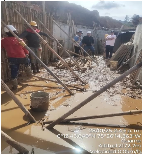
Ilustración 8 descole box culvert
