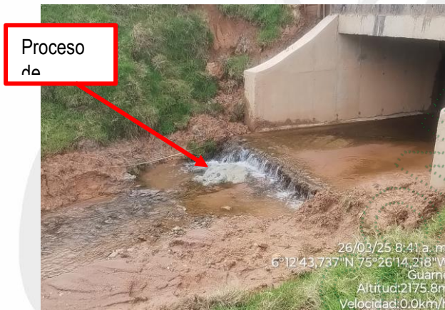
Ilustración 18 Descole del box culvert
