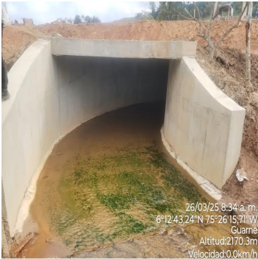
Ilustración 16 Encoche box culvert
