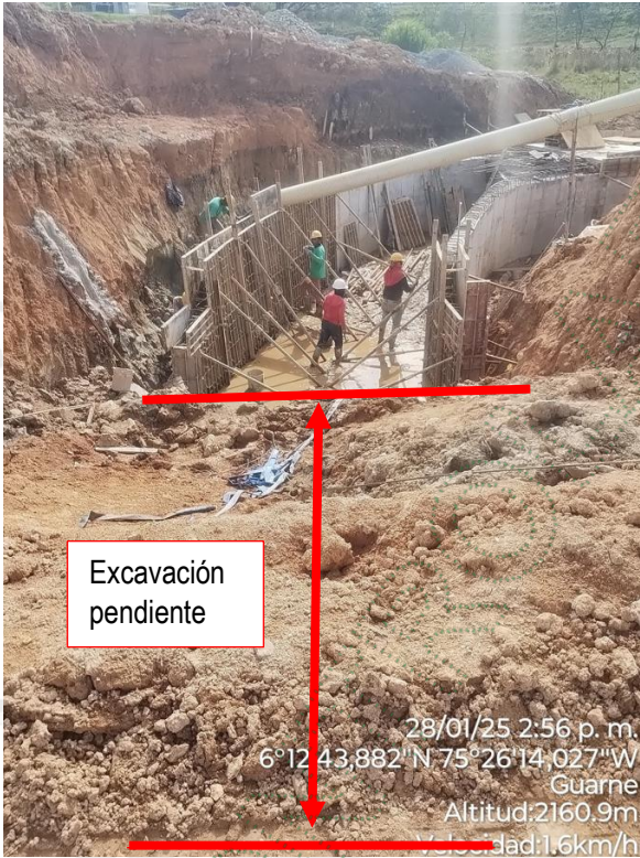
Ilustración 9 tramo final box culvert
