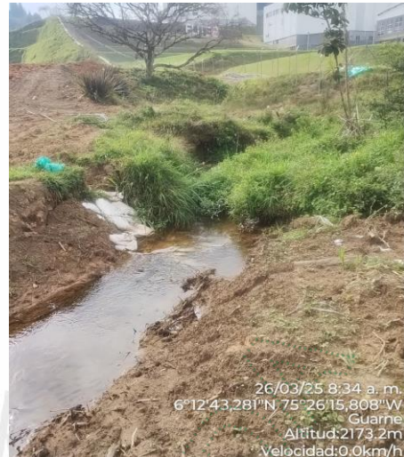
Ilustración 17 aguas arriba encoche box culvert
