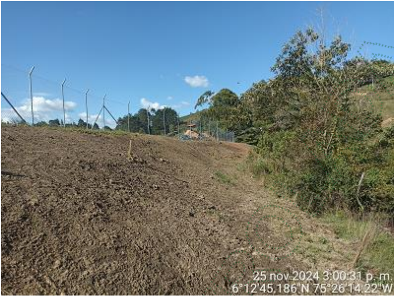
Ilustración 8. Material expuesto sobre la margen izquierda de la Q. La Chorrera
