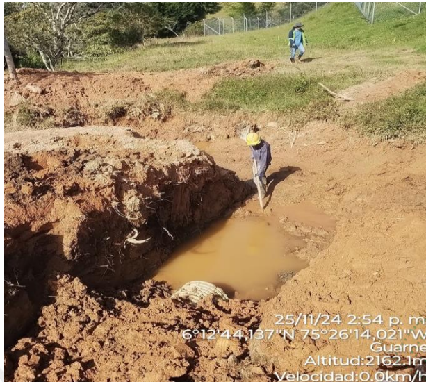
Ilustración 4 actividades manuales para restitución del cauce.
