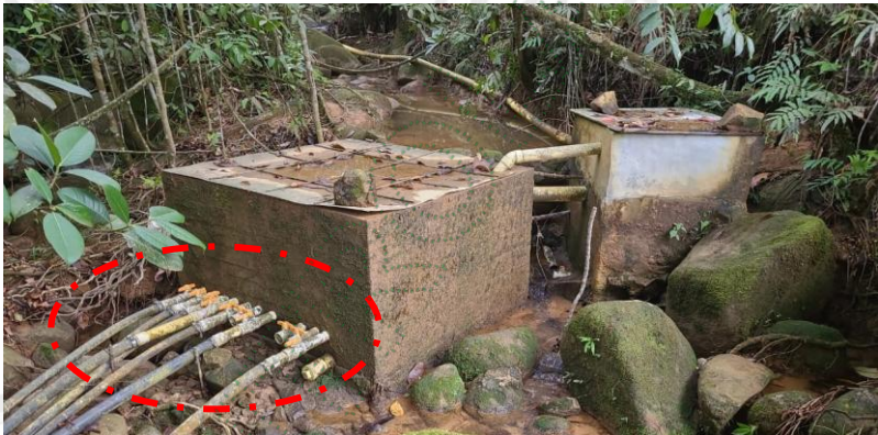
Figura 5. Desarenador y tanque de almacenamiento
