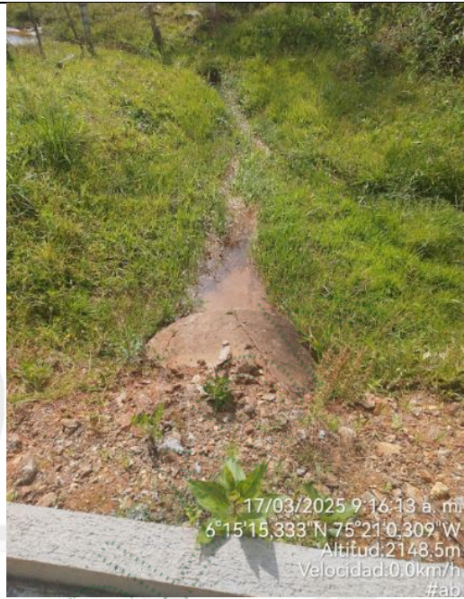
Ilustración N° 4. Tubería en concreto implementada - Aguas abajo
