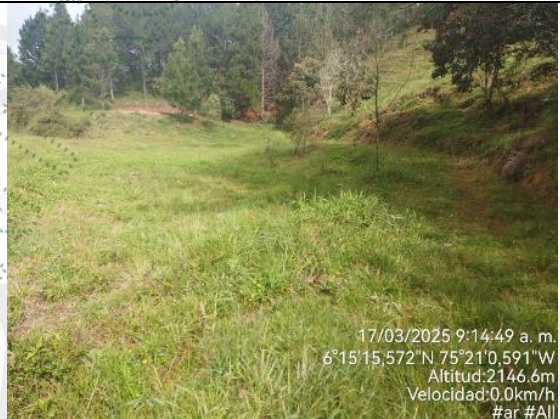
Ilustración N° 6. aguas arriba del sitio de descarga de aguas lluvias, donde se propone construir el canal en concreto
