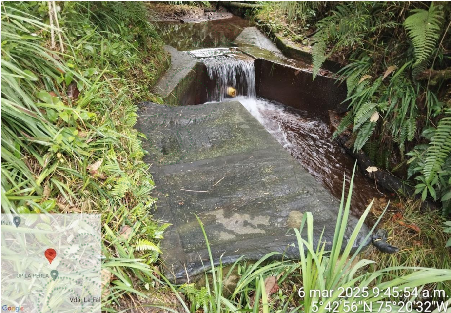
Captación tipo presa de derivación
