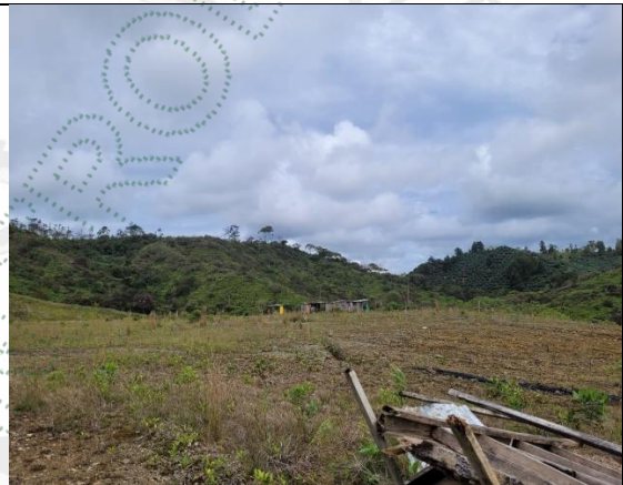
Figura 2. Estado actual explanaciones realizadas para el desarrollo del proyecto
