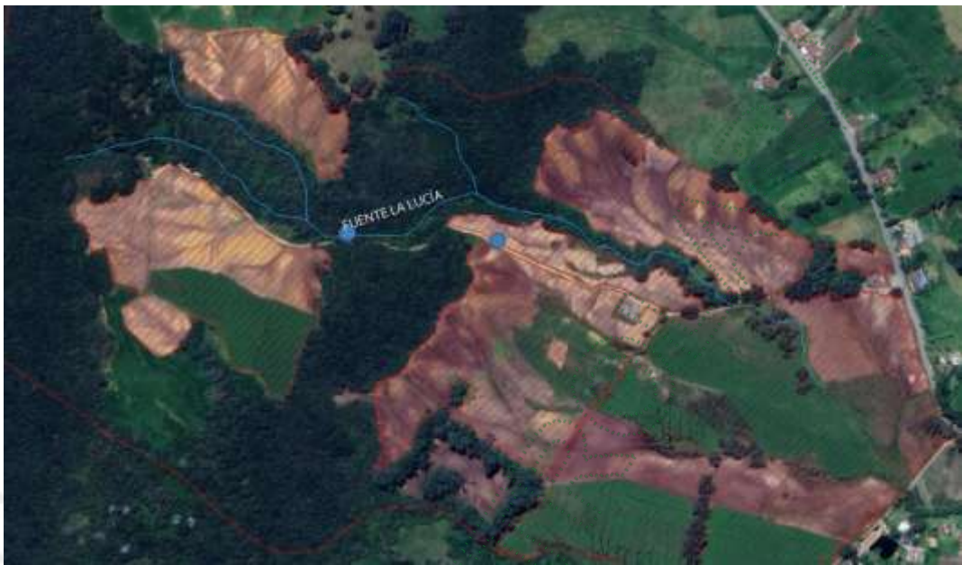
Quintero A. 2025. Punto de Captación Fuente La Lucía y ubicación de la obra inhabilitada.
