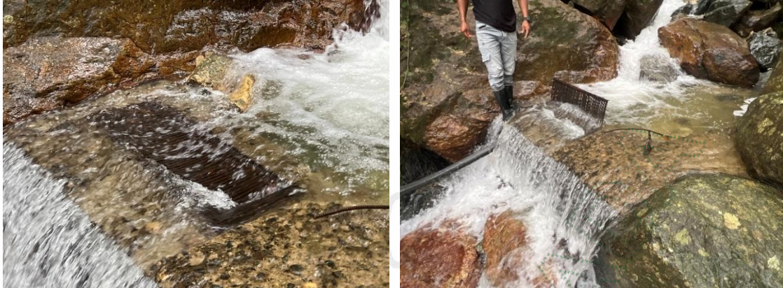
Fotos 3 y 4. Bocatoma. Fuente: Cornare 2025
