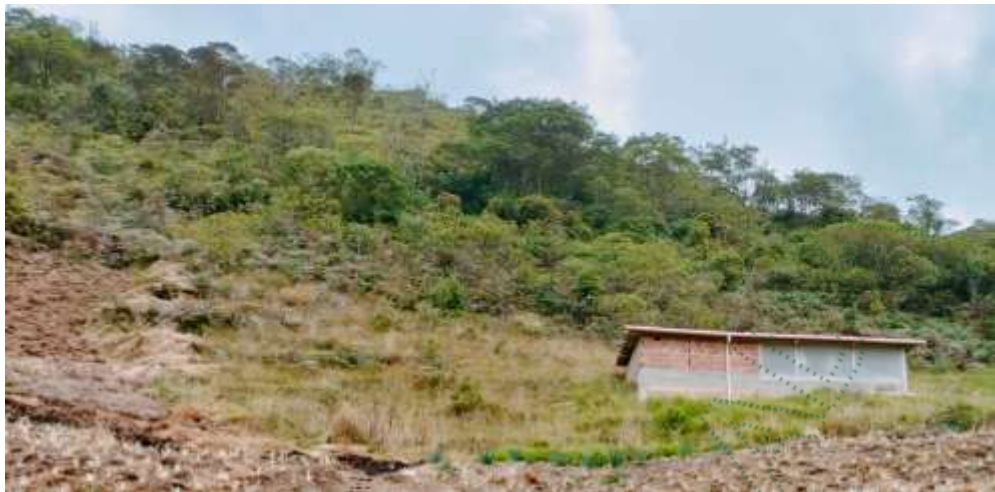
Imagen 5. Pozo séptico construido en el predio
