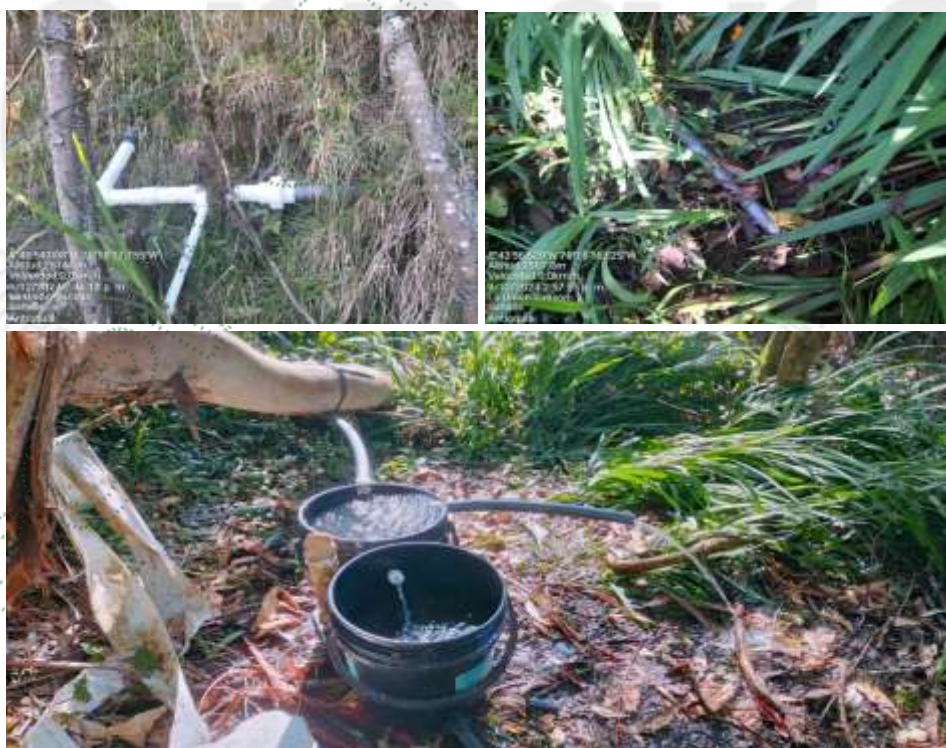
Imagen 1 y 2. Sistema de conducción. Imagen 3. Implementación de la Obra de control de caudal.
