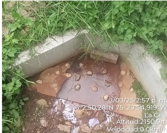
Ilustración 1 Obra de descarga B1
