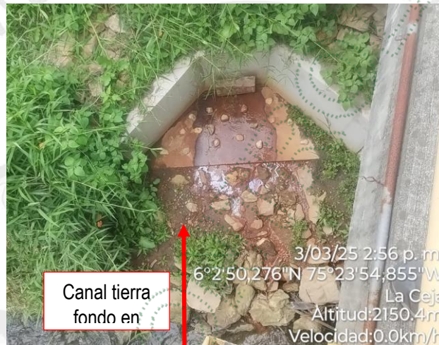
Ilustración 2 canal en terreno natural
