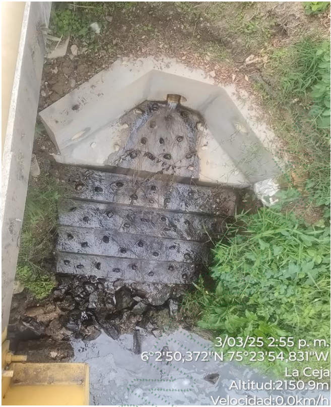
Ilustración 4 Estructura de disipación
