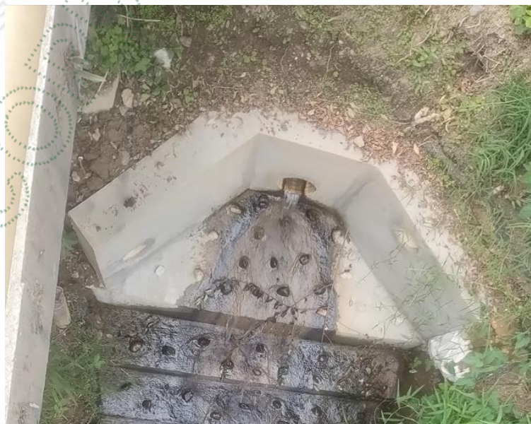
Ilustración 3 Estructura de descarga
