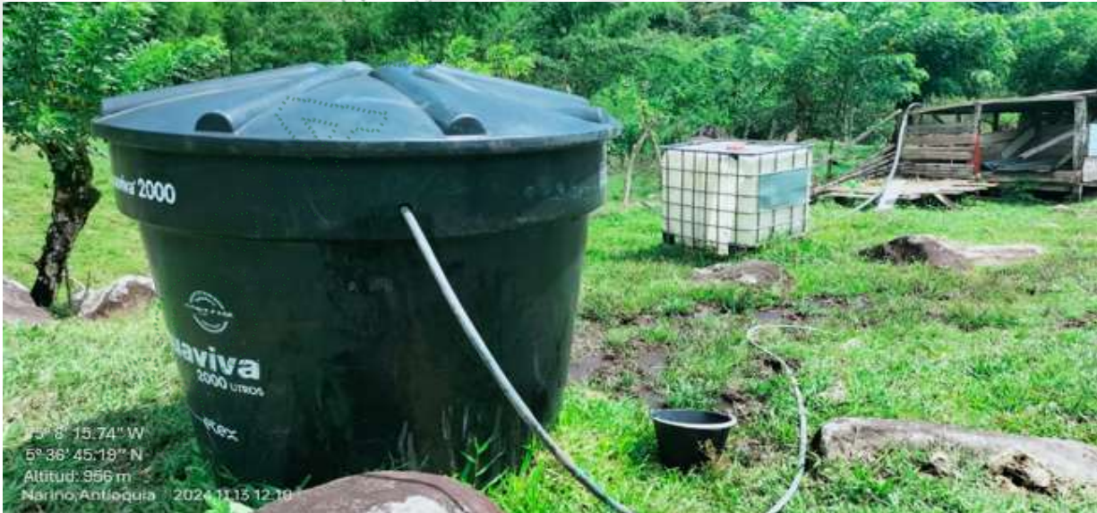
Imagen 6. Sistemas de almacenamiento implementados en el predio.
