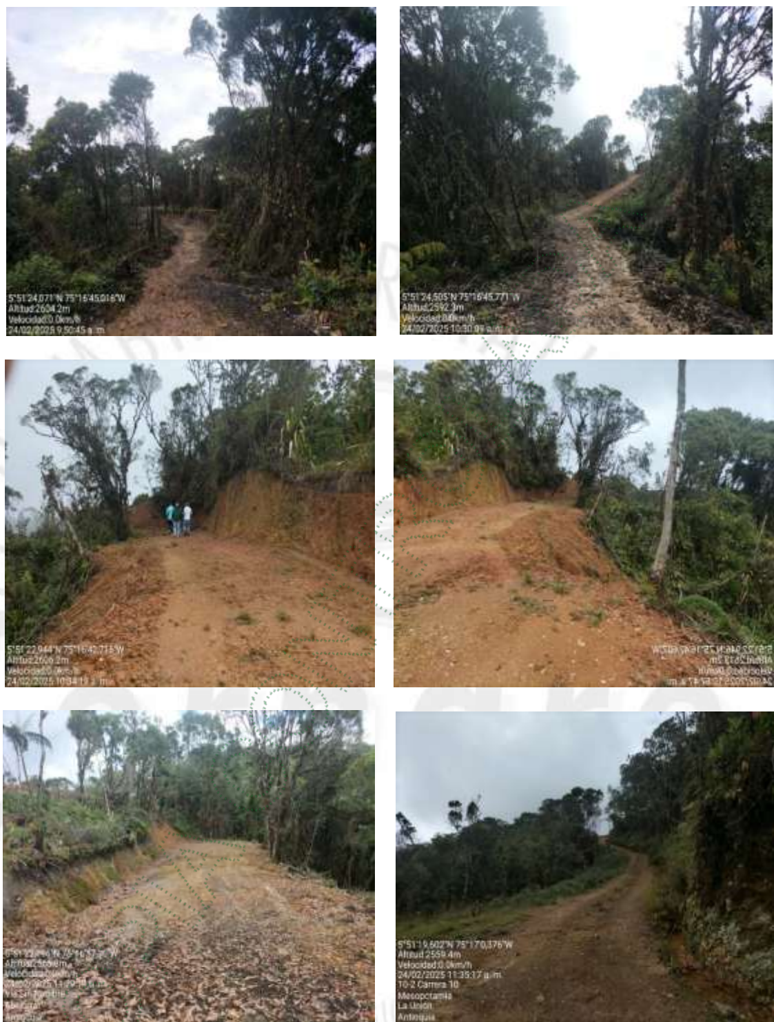
Imagen 1, 2, 3, 4, 5 y 6: Apertura de vías internas.
