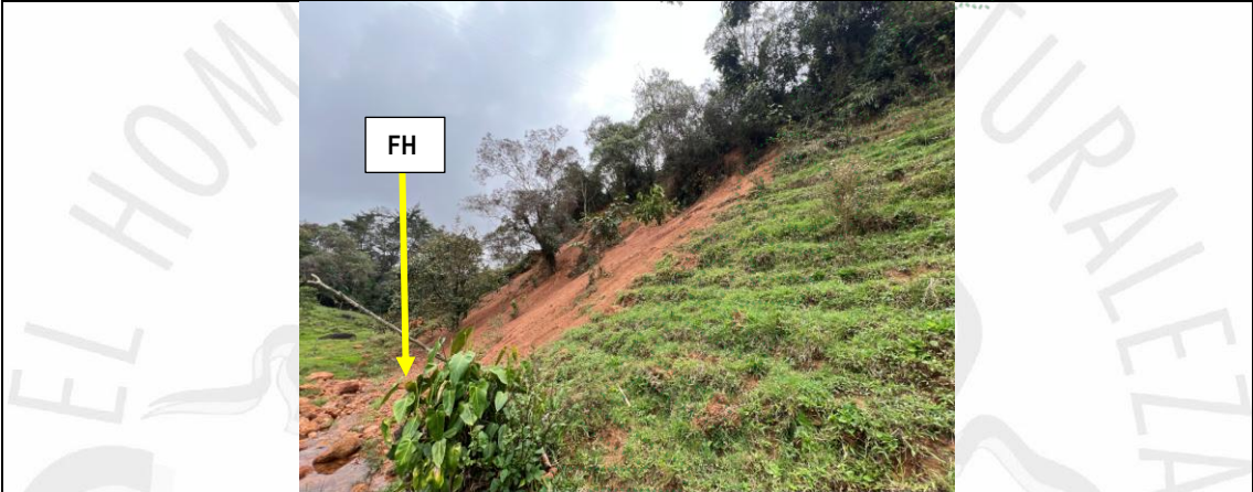
Foto 9. Evidencia talud expuesto por actividad de movimiento de tierras. Fuente: Cornare 2025
