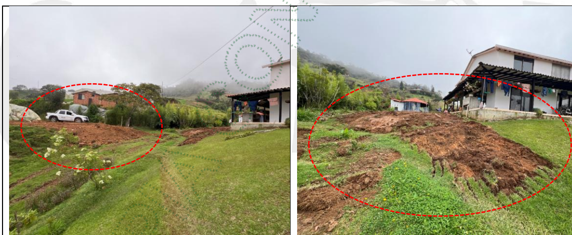
Foto 5 y 6. Material proveniente de la actividad de movimiento de tierras dispuesto cerca de la vivienda del señor Javier Aristizábal. Fuente: Cornare 2025.
