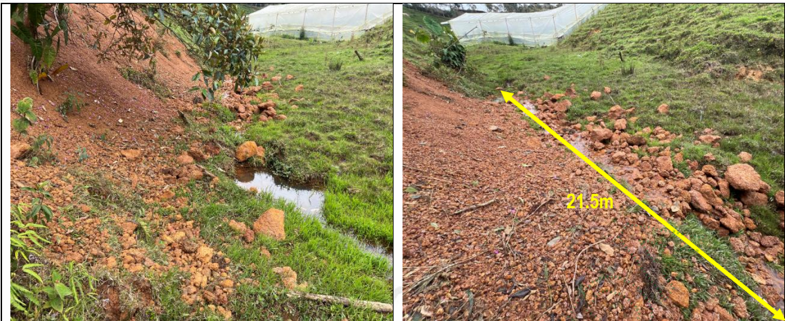
Foto 7 y 8. Evidencia, sedimentación de la fuente hídrica, por actividad de movimiento de tierra en la parte alta del predio. Fuente: Cornare 2025
